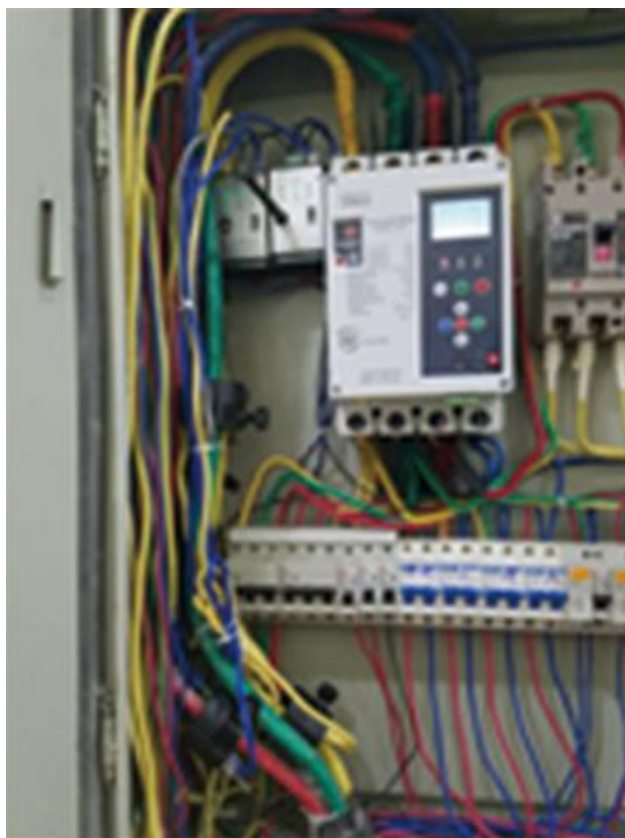
九小消防项目
